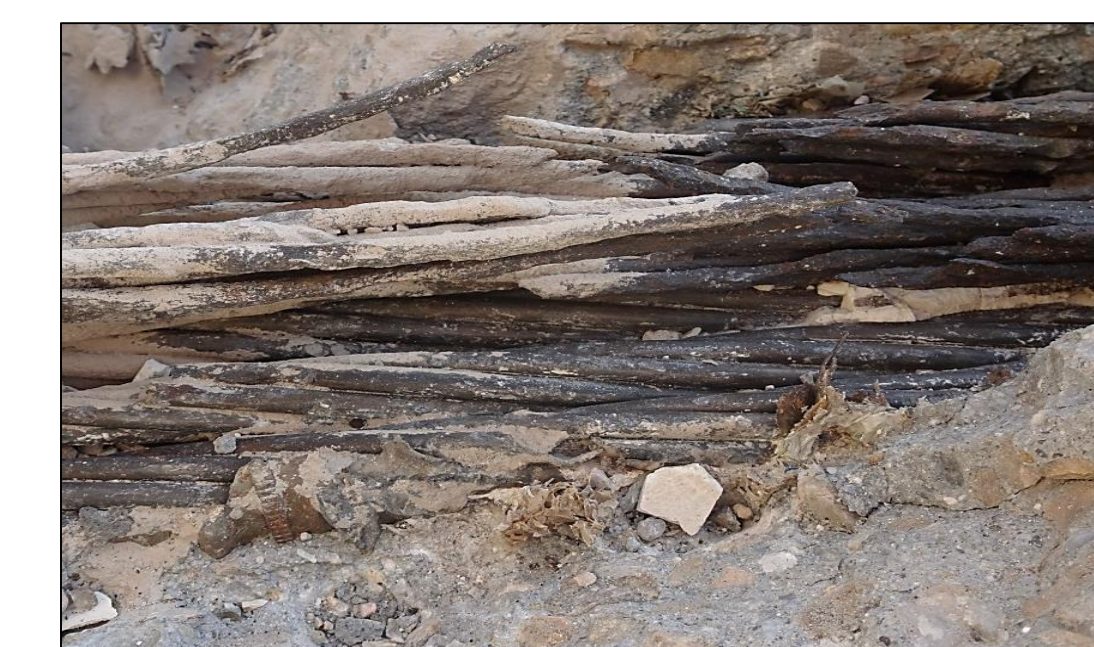
CORROSIÓN Y ROTURA DE ALAMBRES
