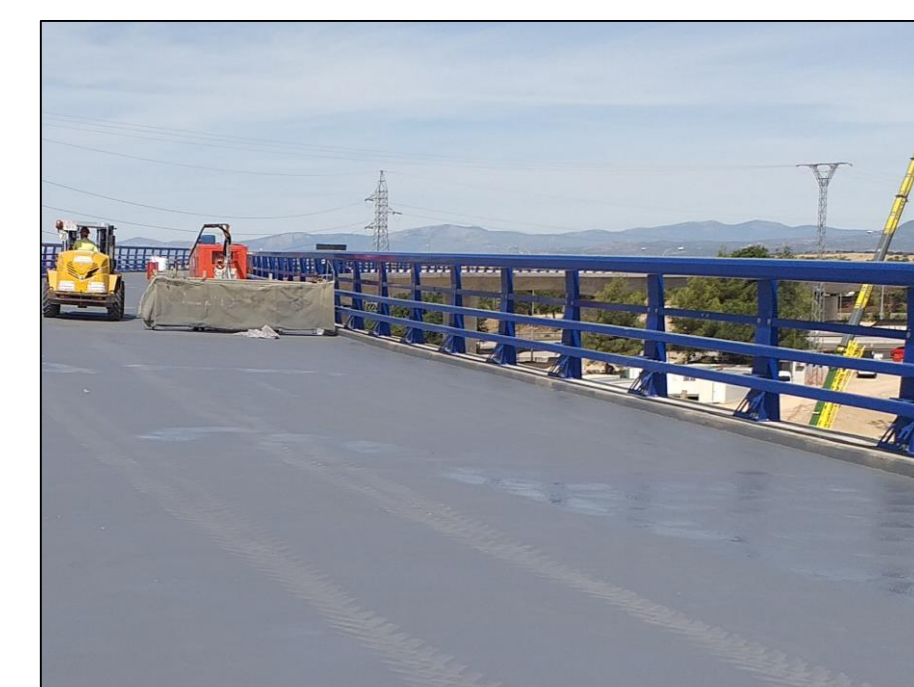
IMPERMEABILIZACIÓN CON POLIUREA
