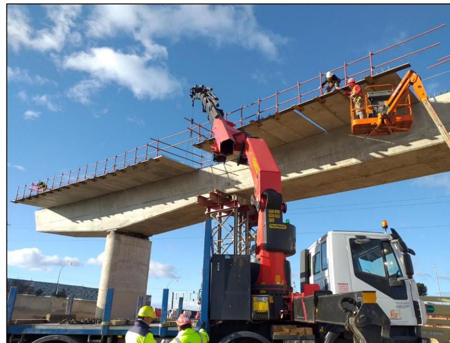
MONTAJE DE PRELOSAS
