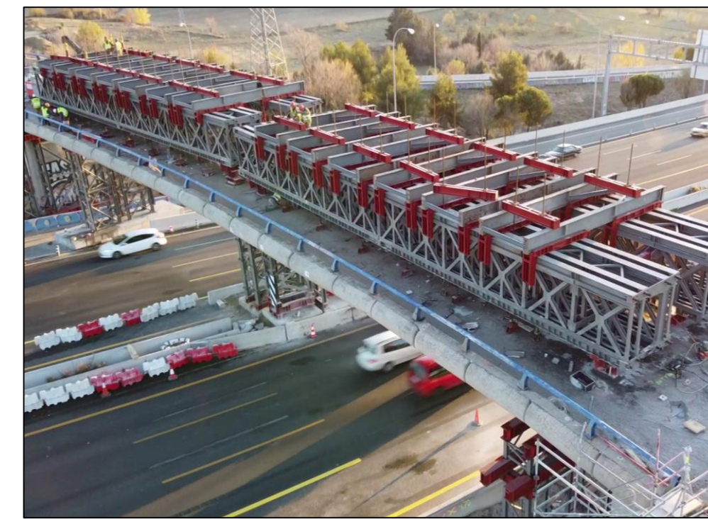
CELOSÍAS METÁLICAS (VANO 6)
