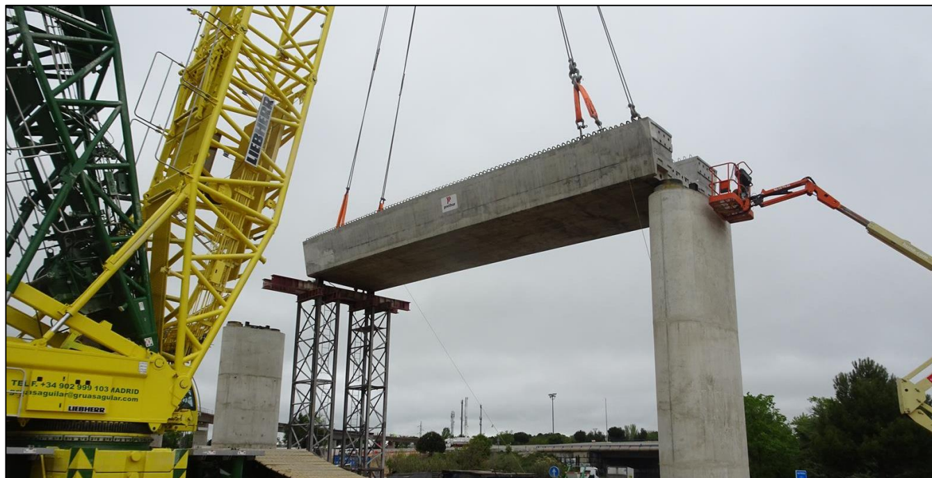
MONTAJE VIGAS
