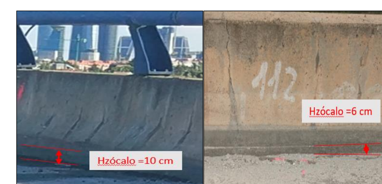
RECRECIDO DE ZÓCALO VANOS 4, 5 Y 6
