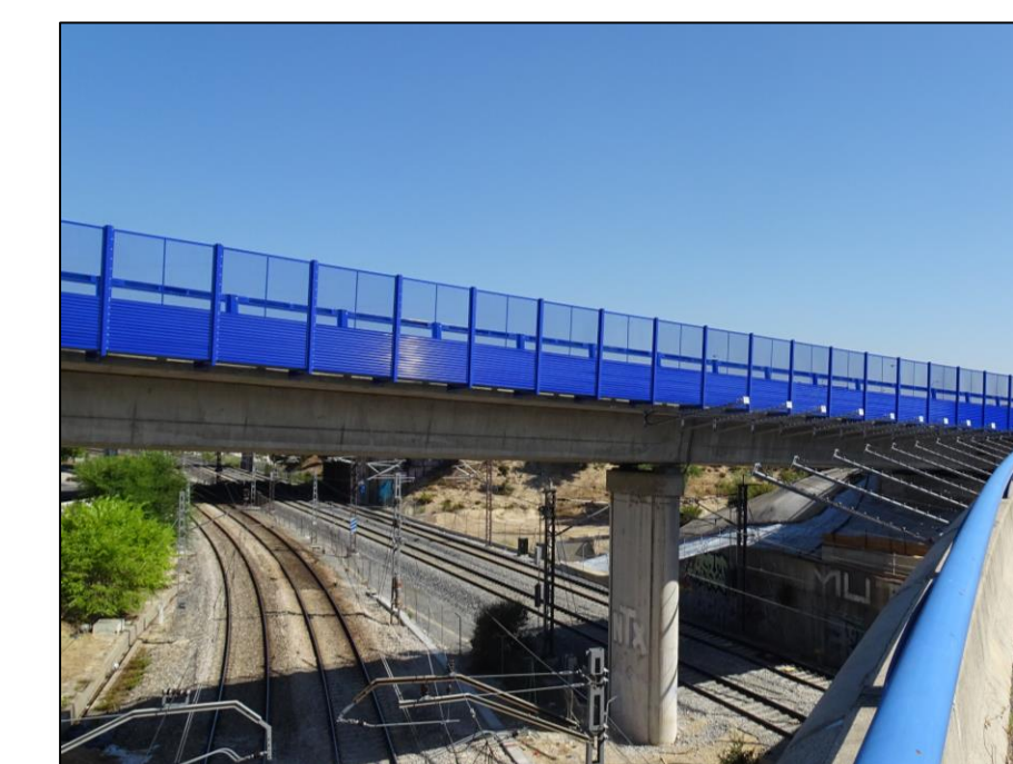
PROTECCIONES ZONA FF.CC.
