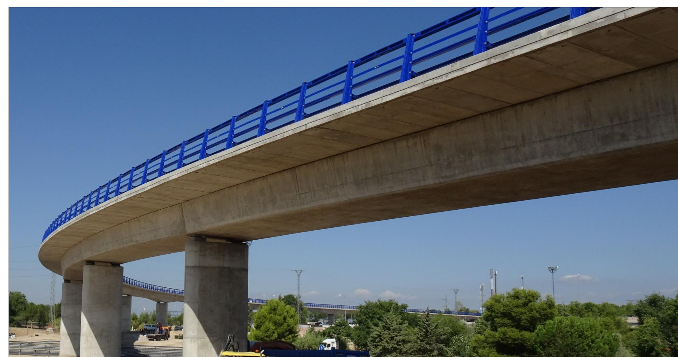
VISTA GENERAL DEL TABLERO
