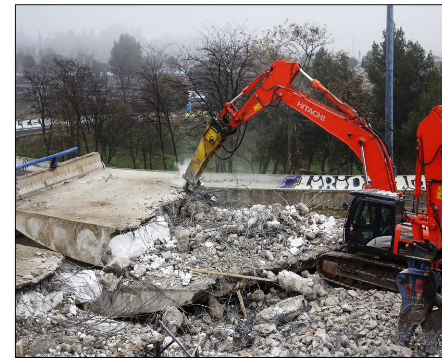
PICADO CON MEDIOS MECÁNICOS
