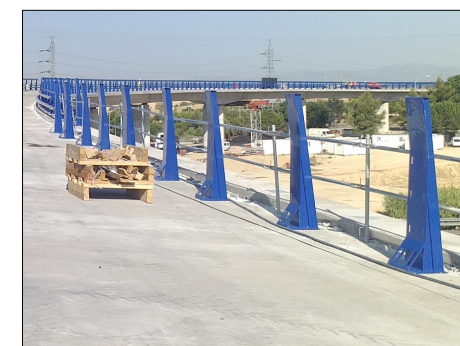
COLOCACIÓN DE PRETIL
