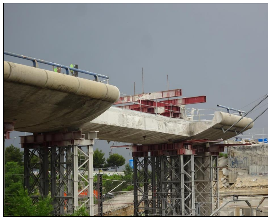
DESMONTAJE VOLADIZO (VANOS 16 Y 17)
