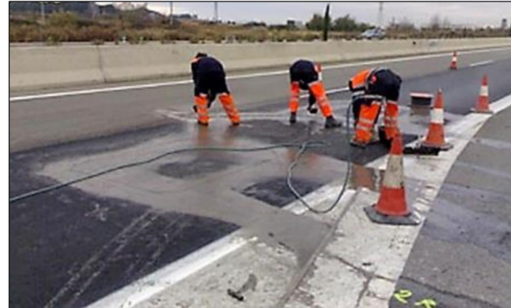
La instalación de este sistema se realiza mediante la colocación de cuatro (4) bucles de inducción embebidos en la calzada, dos por cada carril.
