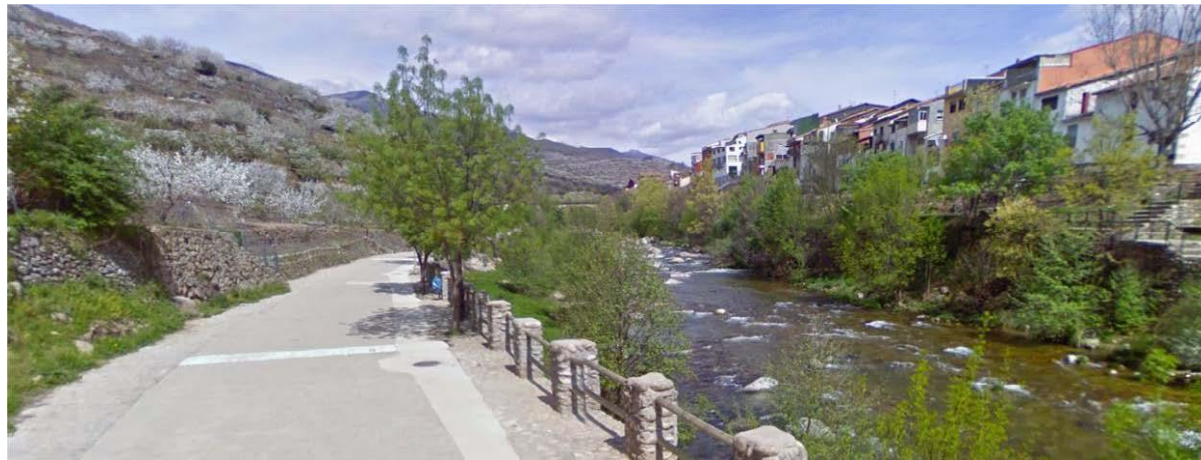
1 Estado actual de la vegetación en el emplazamiento del estribo noroeste
