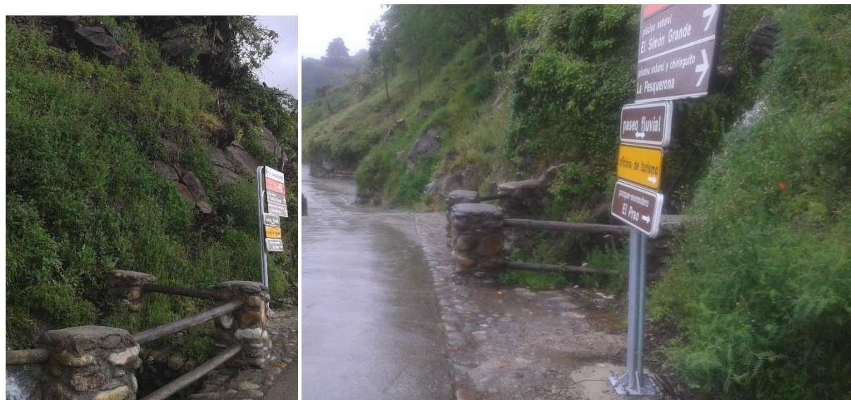
Detalles de paso del torrente bajo el paseo fluvial
