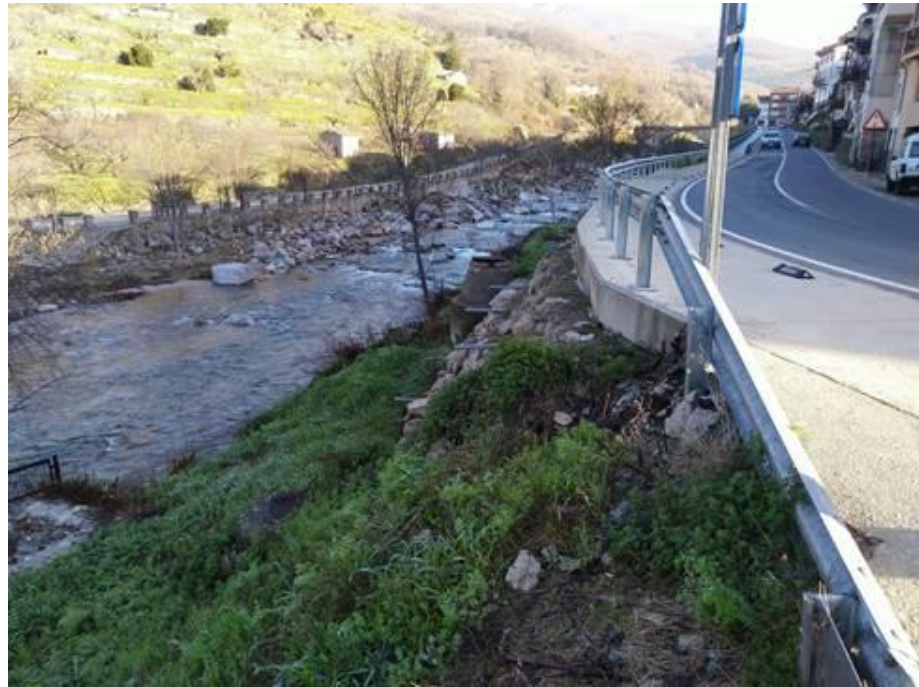
Margen lado pueblo dónde se proyectará el encepado del estribo del nuevo puente
