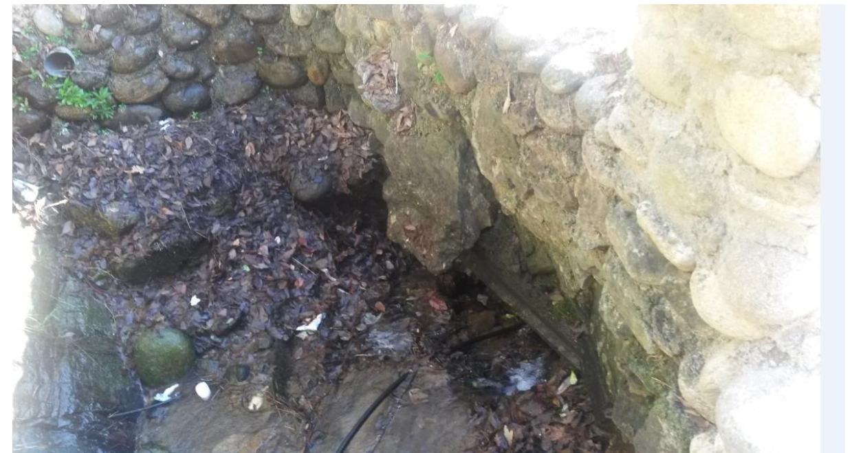
Detalles de la entrada del paso del torrente bajo el paseo fluvial
