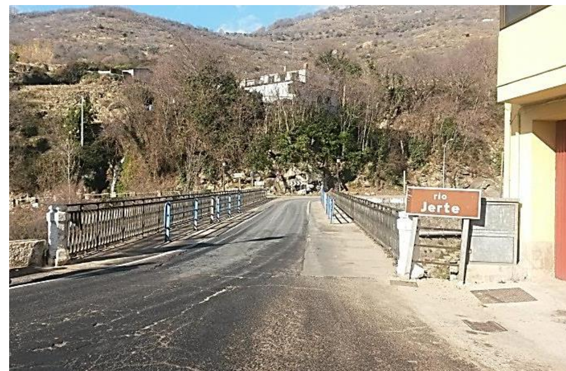
Salida de Cabezuela del Valle por la N-110 a través del puente actual (14/01/2015)
