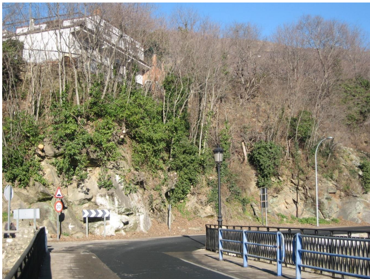
Imagen desde el puente actual de Cabezuela del Valle de la vivienda que se pretende salvar con estas alternativas. Es posible observar la verticalidad del talud natural (14/01/2015)
