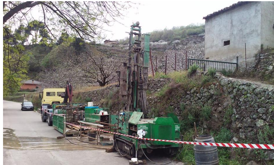
Realización del sondeo S-02.
