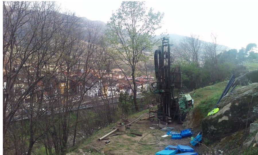
Realización del sondeo S-04.
