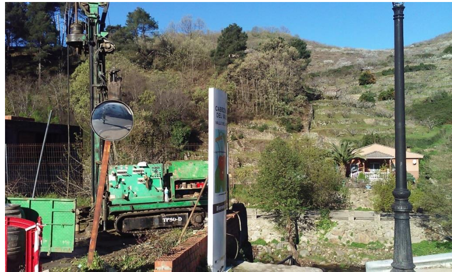
Realización del sondeo S-01.
