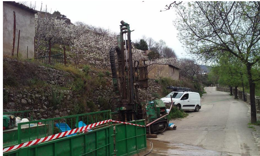
Realización del sondeo S-03.
