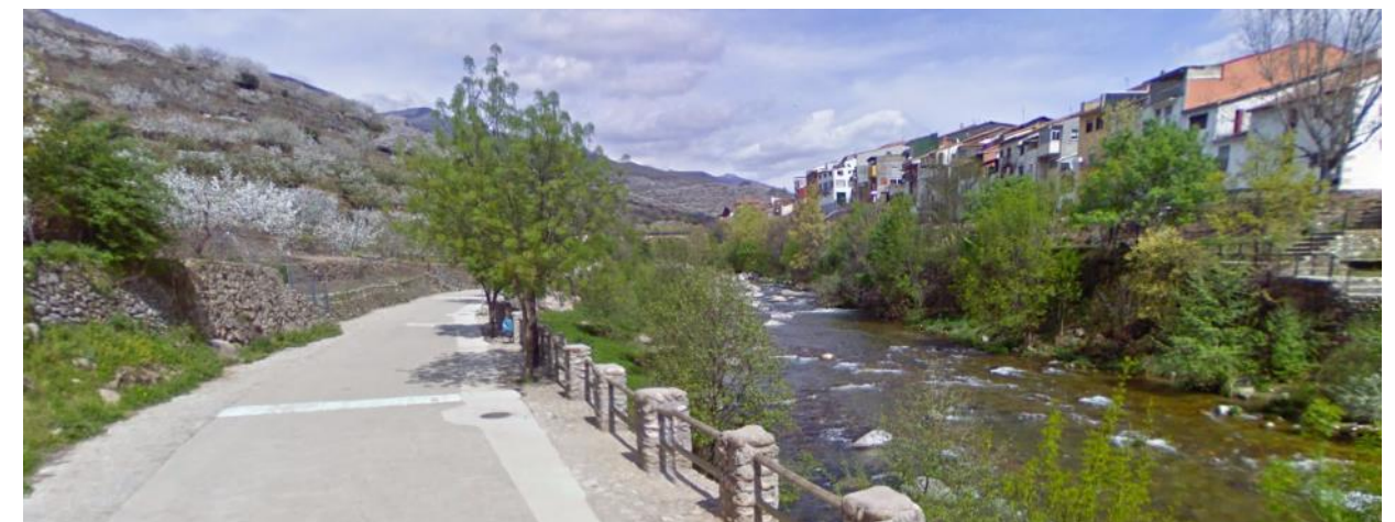
Estado actual del emplazamiento del estribo 2 (paseo fluvial existente).
