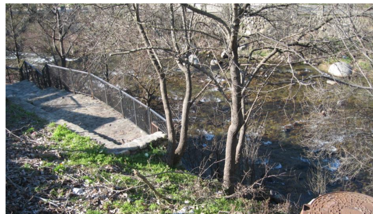
Estado actual del emplazamiento del estribo 1 (mirador y acceso a la playa fluvial).
