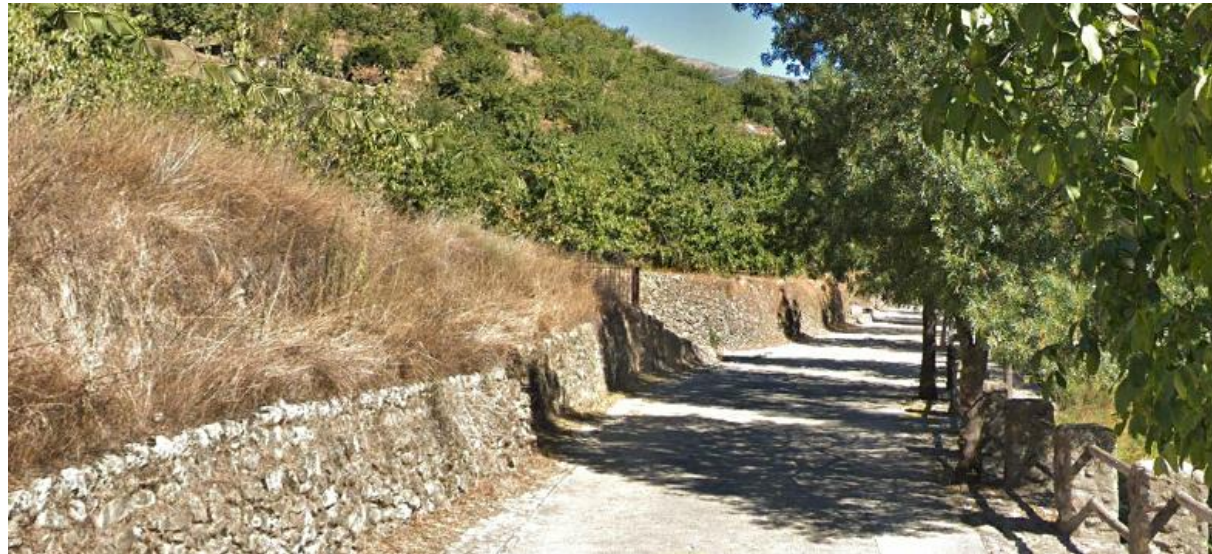
Estado actual del emplazamiento del estribo 2 (paseo fluvial).
