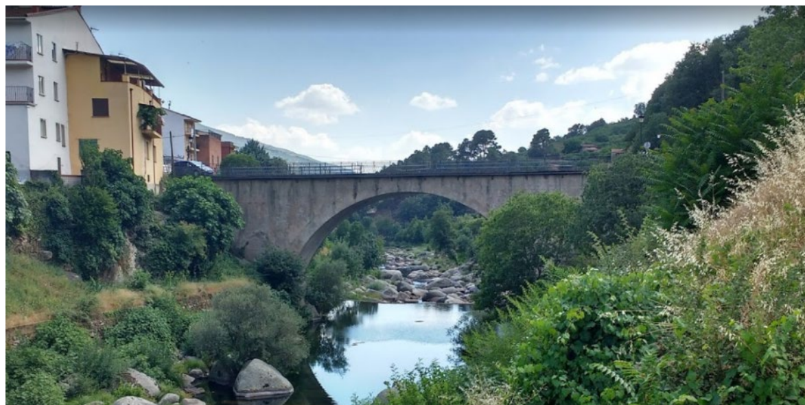
Puente existente en la carretera N-110 (aguas arriba del emplazamiento del nuevo puente).
