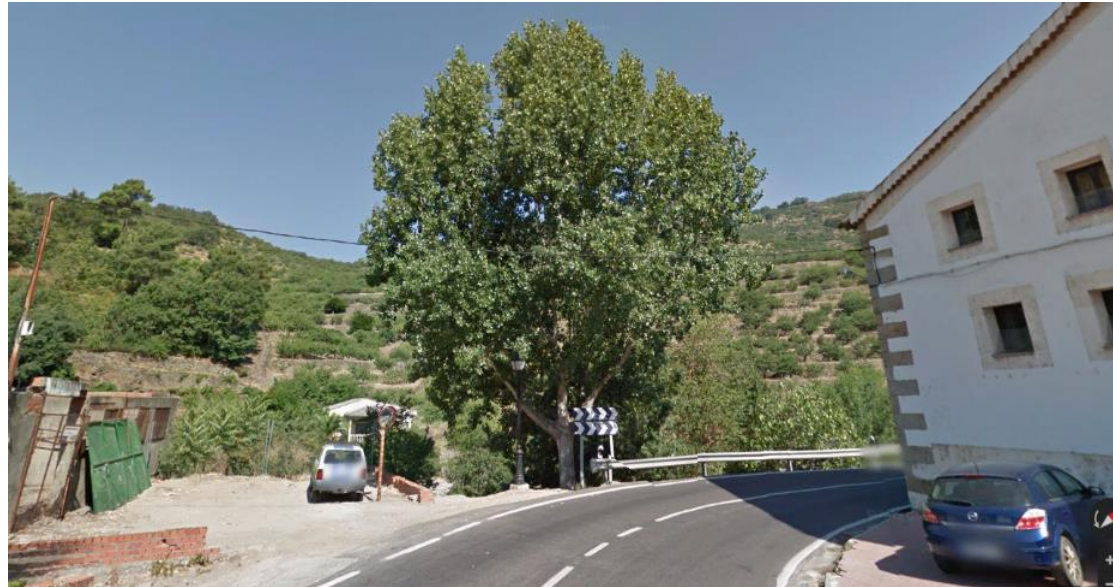
Estado actual del emplazamiento del estribo 1 (vista desde carretera N-110).
