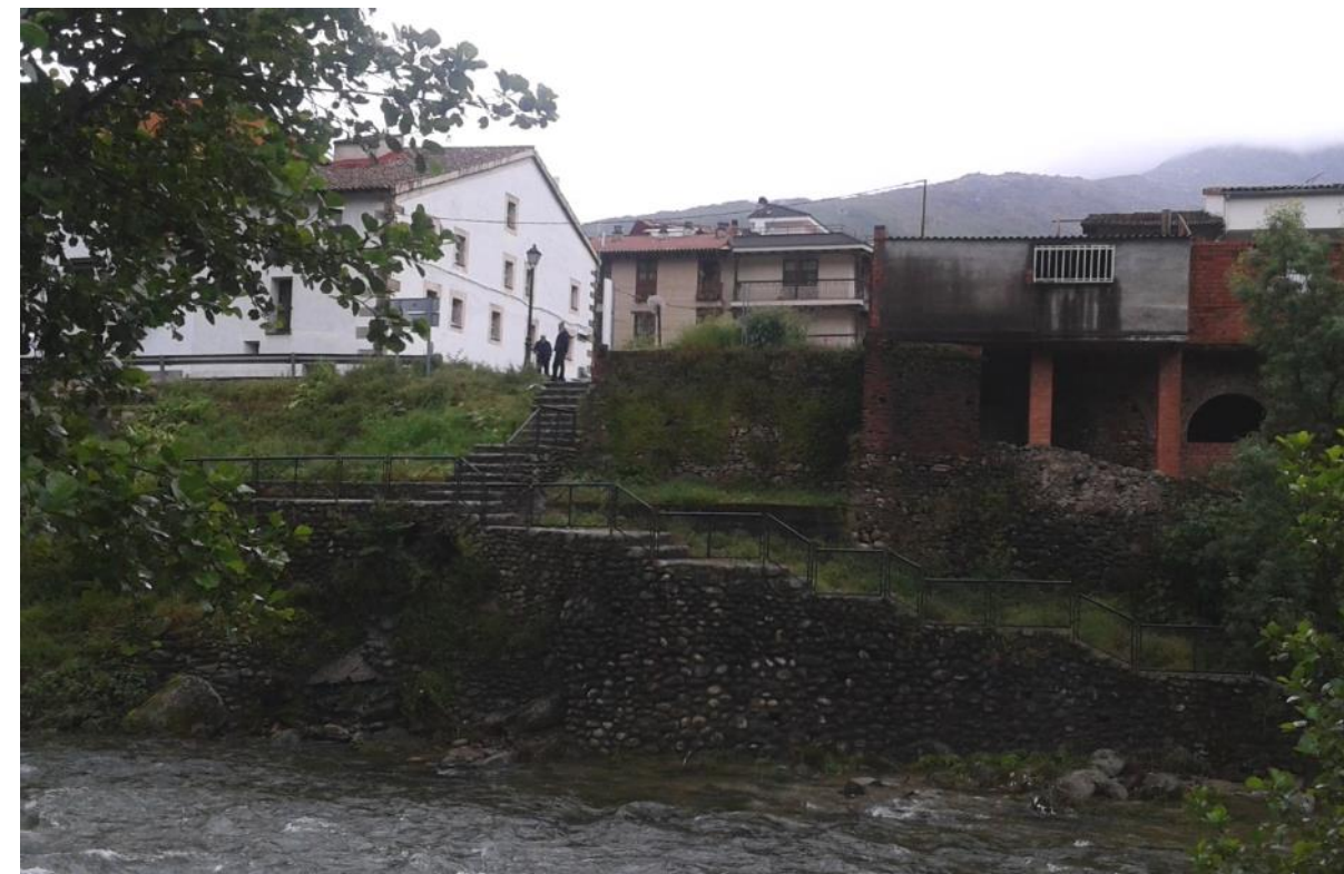
Estado actual del emplazamiento del estribo 1 (mirador y acceso a la playa fluvial).
