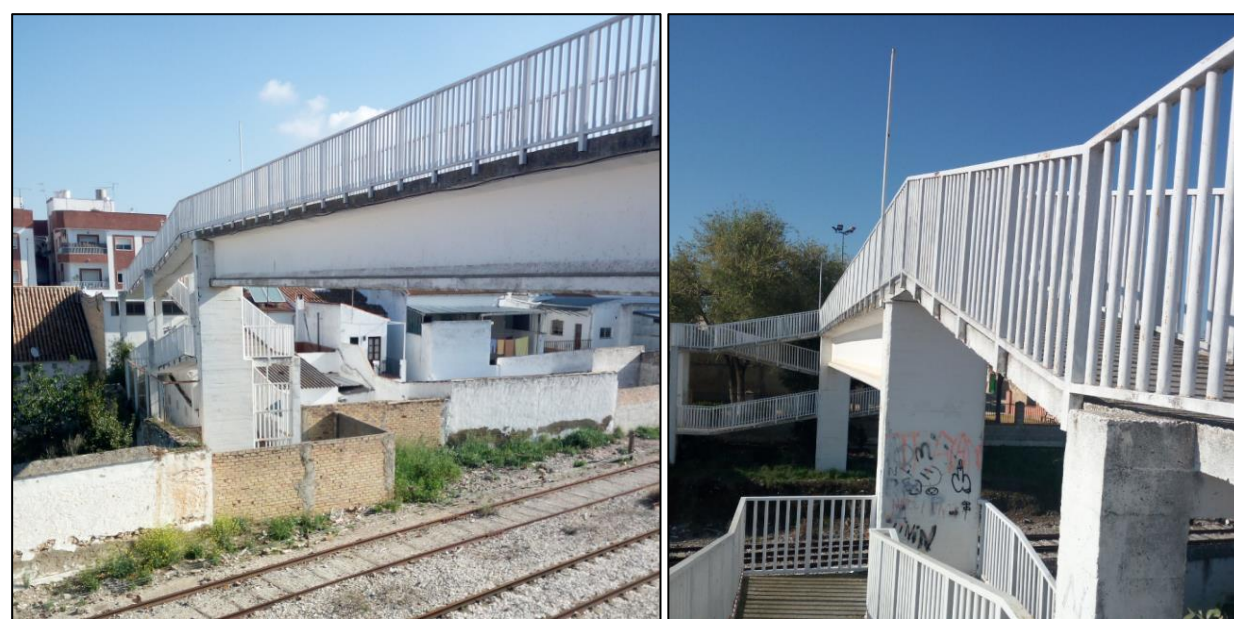
Pasarela existente en p.k. 94/770
